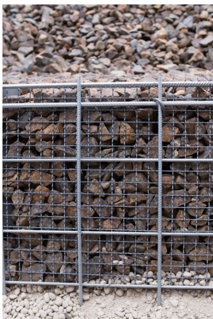
Remplissage en ballast 30/60
