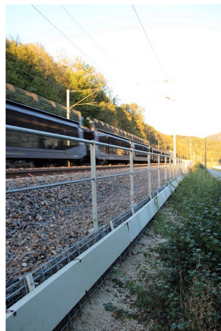
Garde-corps avec caniveau en façade
